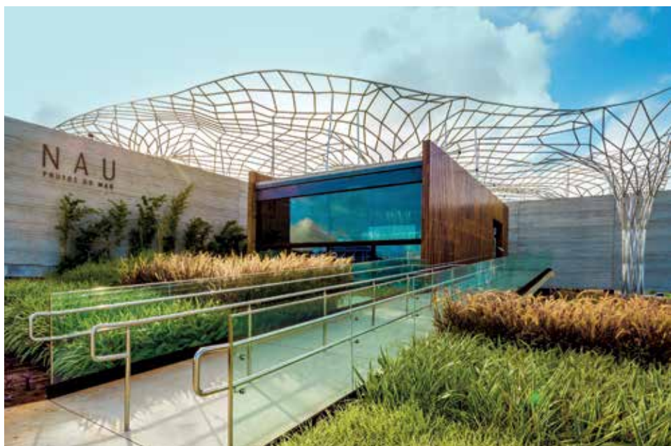
Vigas Vierendeel em aço viabilizam balanços de 5,5 e de 10 m na parte frontal do salão principal, que tem 17 m de largura e 40 m de comprimento
