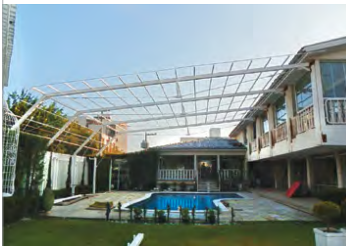
Figura 7: Estrutura da cobertura Terrasse Jardim em execução (Fonte: arquivo Projectação)
