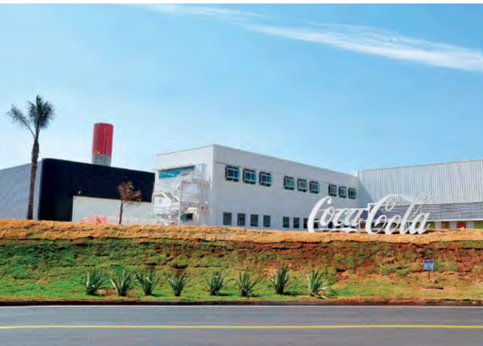
Utilização de painéis de metal permitiu a obra de ampliação da indústria de refrigerante com menor interferência na produção
